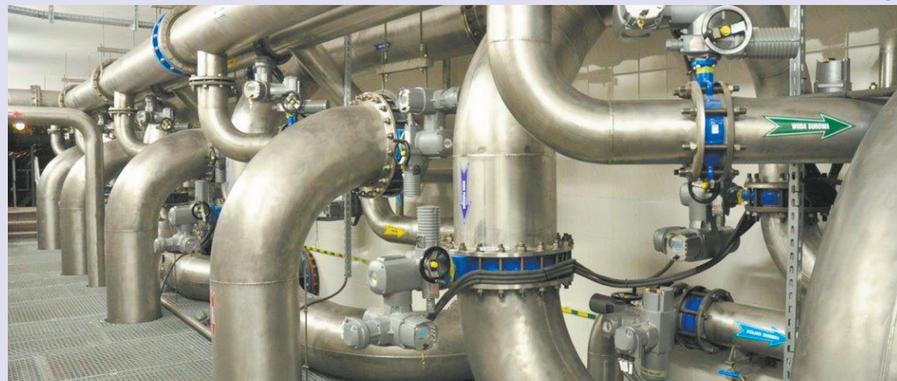
Nowa galeria rurociągów Stacji Uzdatniania Wody w Zawadzie.
