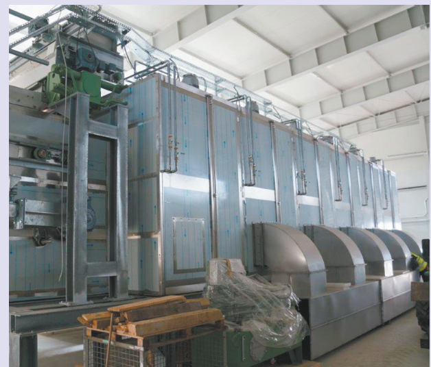
Montaż elementów linii suszarniczej - Oczyszczalnia w Opolu.
